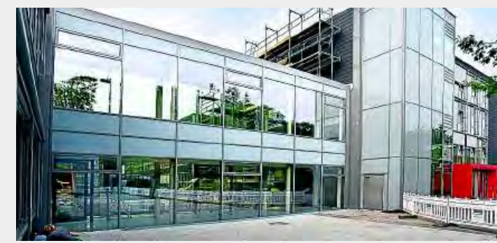
Der Übergang vom Alt- zum Neubau auf zwei Etagen.
